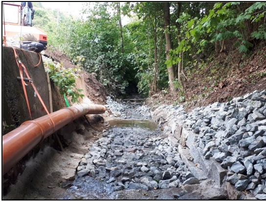
Abb. 6: nach der Maßnahme: Ufersicherung und rauh strukturierte Gewässersohle, 23.07.2018
