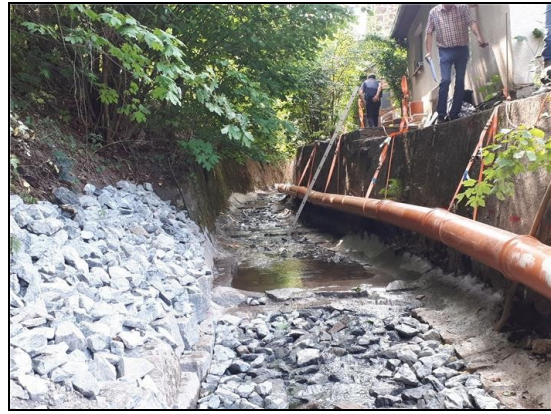
Abb. 7: nach der Maßnahme: Ufer-, Sohl- und Böschungssicherung, 23.07.2018
