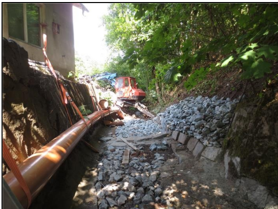
Abb. 4: während der Maßnahme: Einbau Sohl- und Böschungssicherung, 19.07.2018
