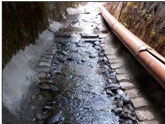
Abb. 5: nach der Maßnahme: Gesicherte Ufermauern und mit gewässertypischem Grobmaterial rauh befestigte Gewässersohle, 23.07.2018
