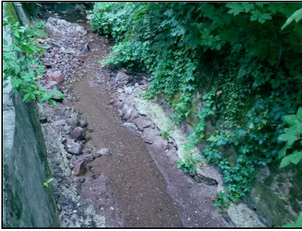
Abb. 2: vor der Maßnahme: Ausgeräumte und eingetiefte Gewässersohle, 18.08.2014
